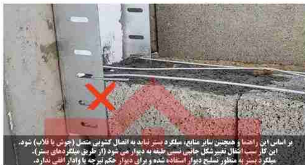
شکل پ-۷-۳: ایراد متداول قلاب نمودن میلگرد بستر به اتصالات کشویی.
