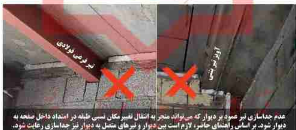
شکل پ-۷-۲: ایراد متداول عدم جداسازی بین تیر و دیوار.
