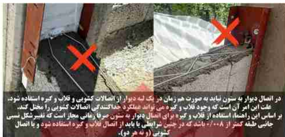
شکل پ-۷-۷ ایراد متداول استفاده همزمان از اتصال کشویی و قلاب و گیره جهت برقراری اتصال بین دیوار و ستون
