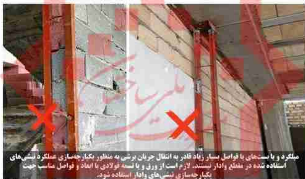
شکل پ-۶-۷ ایراد متداول مربوط به بست‌های مورد نیاز جهت یکپارچه سازی مقطع وادار
