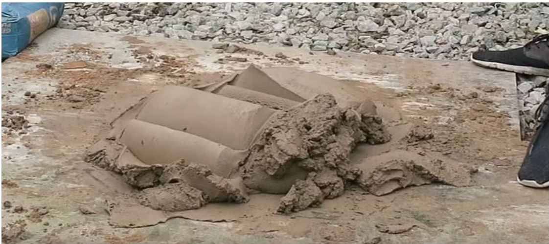
شکل ۱-۵. شکل ظاهری ملات خامه ای مناسب برای کارهای بنایی
